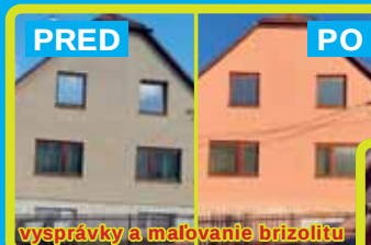
vysprávkovanie a maľovanie brizolitom
