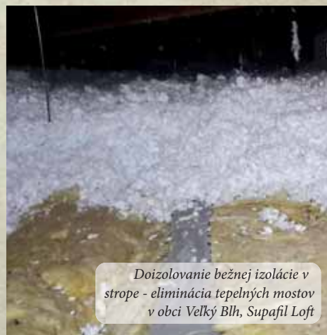
Zateplenie stropu fúkanou izoláciou Isocell v obci Domaša
