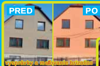
vysprávkovanie a maľovanie brizolitom
