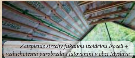
Zateplenie strechy fúkanou izoláciou Isocell + vzduchotesná parozbrzda s latovaním v obci Myslava
